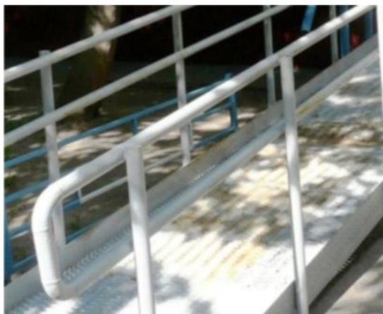
Поверхность захвата поручня не должна прерываться конструктивными элементами креплений или архитектурными элементами и должна быть непрерывной для обхвата рукой.
